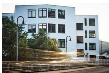
Die neue LED-Straßenbeleuchtung in Hausen. ©Christoph Meinschäfer
