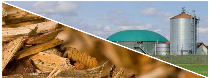
Die Quellen der Nahwärme in Teningen-Oberdorf: Die Biogas-Anlage vor Ort und regionale Holzhackschnitzel
