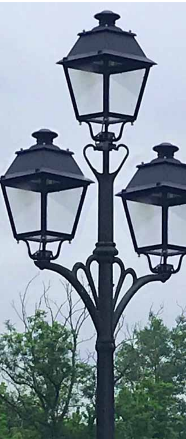
Vorher – Nachher: Die Leuchtenbestand in Lauffen (oben) stammt aus den 80er Jahren. Die neuen energie-sparenden Leuchtenmodelle (unten) passen in Stil und Montage perfekt auf die bestehenden Masten.
